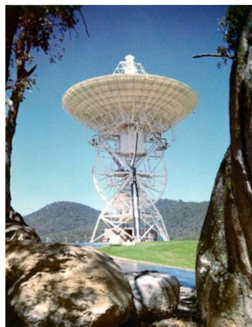
L'antenne Honeysuckle. La salle d'émission est la structure carrée située directement sous l'antenne. Photos par Hamish Lindsay, scan par John Saxon.
