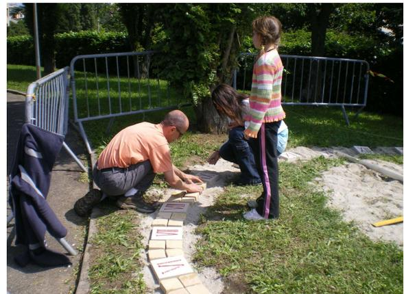
Fig.21. Pose des dalles sur un lit de sable.
